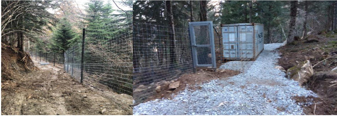
Fotografías de las obras y del estado actual de la infraestructura de acogida de osos problemáticos.
